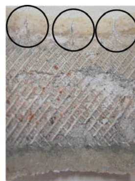
図8 試験後に電極から剥がした主絶縁接触面での水素漏洩箇所(丸印内)
