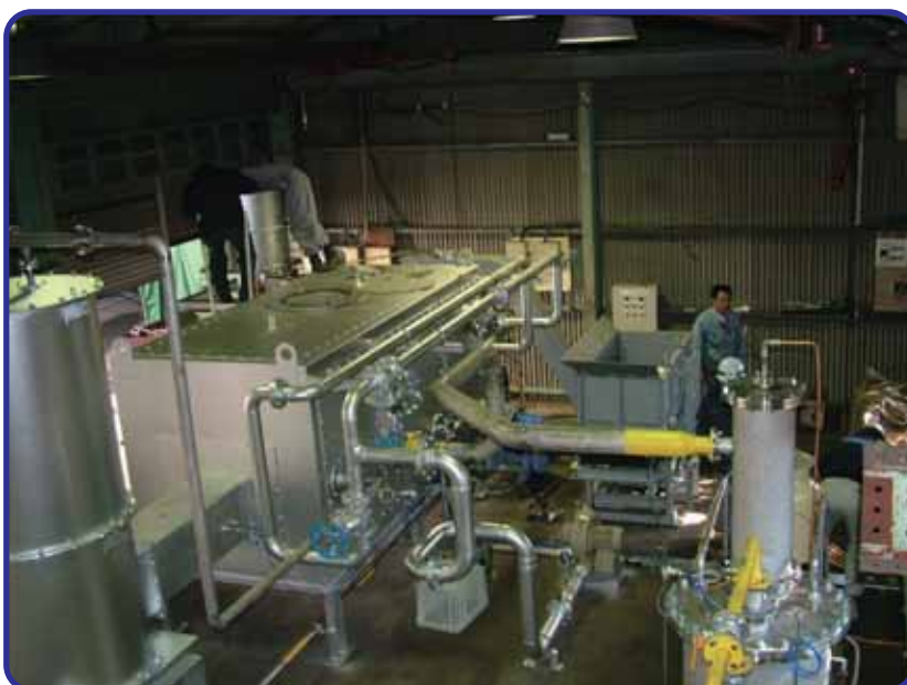
バイオマス燃料ガスエンジン 発電システム (長崎総合科学大学)
