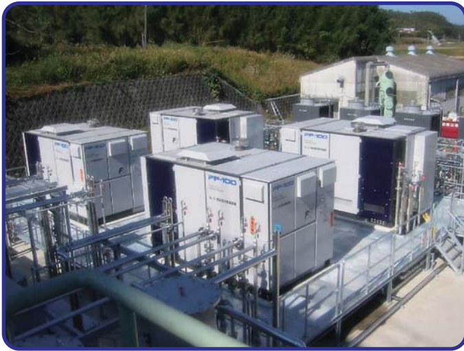
4台設置のPAFC（熊本北部浄化センター） （富士電機アドバンステクノロジー）
