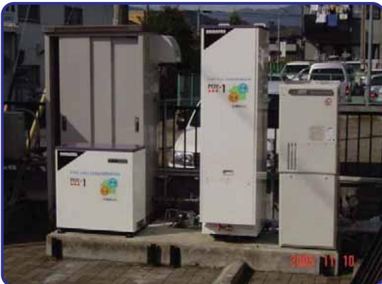
試験中の1kWPEFCシステム
